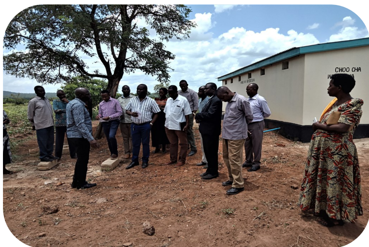
Wajumbe wa Kamati ya Fedha wakikagua ujenzi wa madarasa 3 na matundu 13 ya vyoo shule ya Msingi Mnekezi fedha za EP4R 2017
