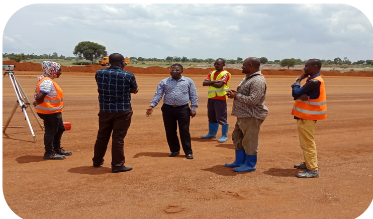
Waziri wa Nishati na Mbunge wa Jimbo la Chato Mhe. Dkt. Medard Kalemani (mwenye miwani) akikagua maendeleo ya ujenzi wa kituo kipya cha mabasi kinachojengwa kijiji cha Kahumo kata ya Muungano na kam-puni ya Mayanga Construction kwa gharama ya shilingi Bilioni 5.3
