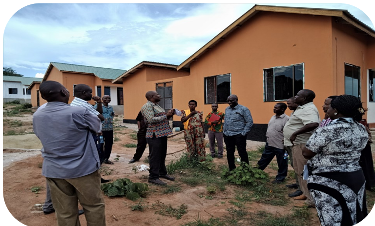
Kamati ya Fedha, Uongozi na Mipango wakiwa kwenye ziara ya kukagua ujenzi wa Nyumba sita za walimu shule ya sekondari Ile-mela zenye thamani ya shilingi milioni 152 kwa ufadhili wa TEA
